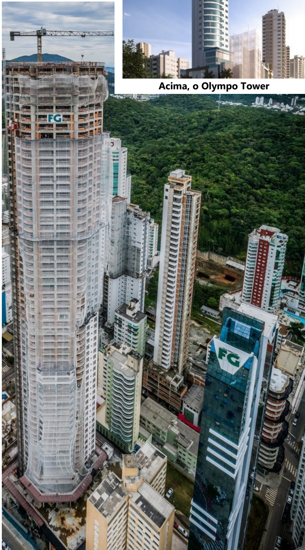
Construção do Infinity Coast, composto por 70 lajes
